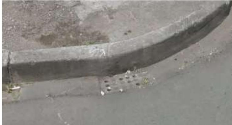
**Fig. 3.16.** Presencia puntos de drenaje en la intersección de las calles 24 de Mayo y S/N. Dichos puntos posee una tapa de hormigón y sus respectivas canaletas de drenaje.
