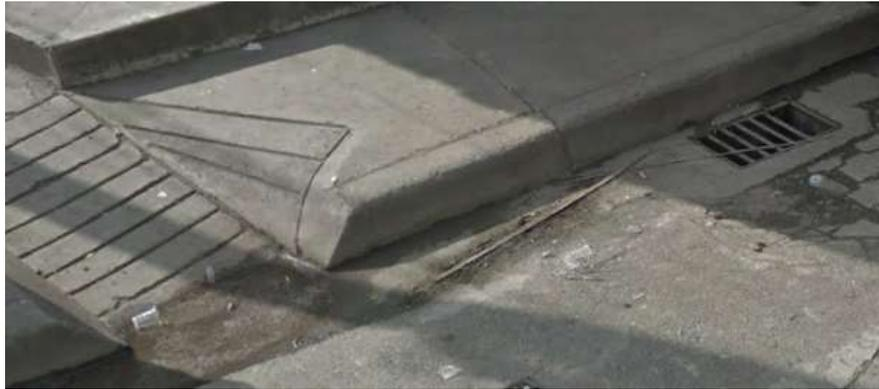
**Fig. 3.9.** Solución entre la rampa de la acera, las canaletas y el punto de drenaje pluvial.
