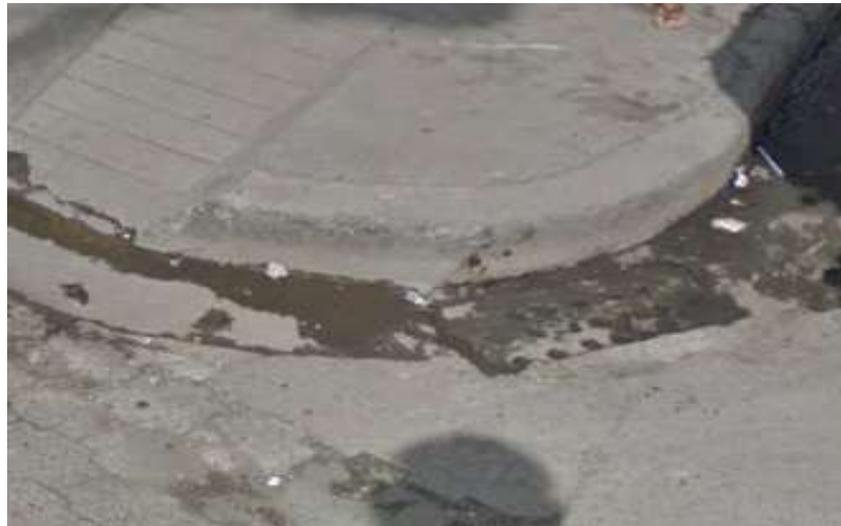
**Fig. 3.10.** Visualización de punto de drenaje pluvial (hormigón) y canaletas de direccionamiento de aguas pluviales en la intersección de las calles 24 de Mayo y Rocafuerte.
