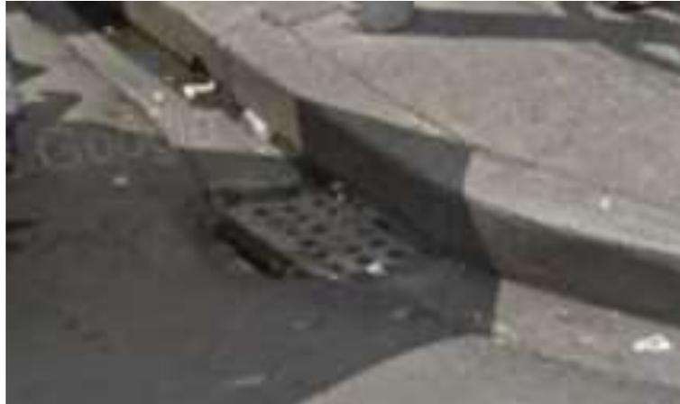
**Fig. 3.15.** Presencia de un punto de drenaje en la intersección de las calles 24 de Mayo y Eplicachima. Dicho punto posee una tapa de hormigón y sus respectivas canaletas de drenaje.
