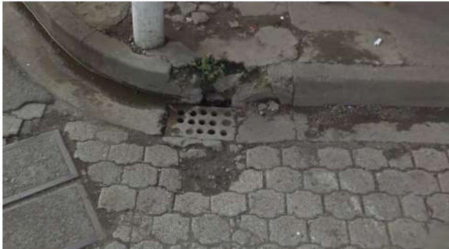
**Fig. 3.14.** Avistamiento de los puntos de drenaje en la intersección de las calles 24 de Mayo y Gral. Eloy Alfaro. Se observan tapas de hormigón armado y la tapa de su respectiva caja de revisión.
