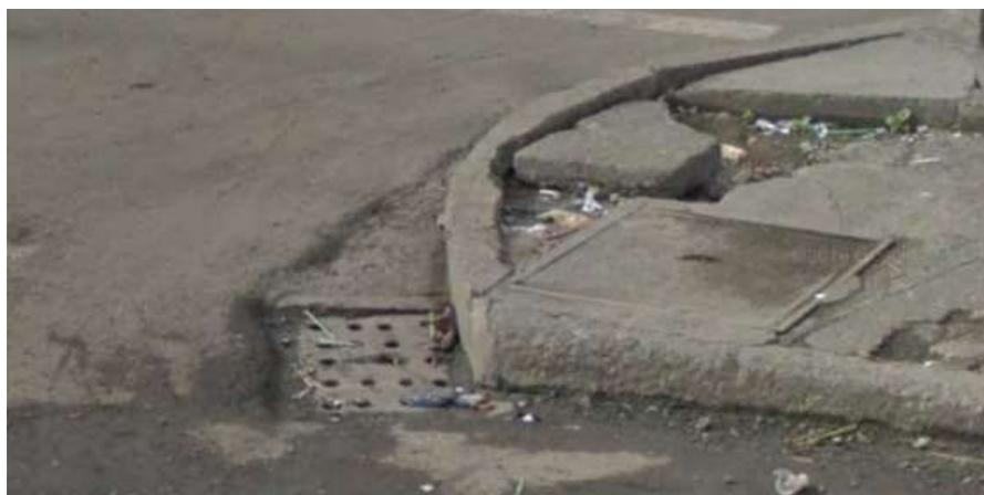
**Fig. 3.13.** Avistamiento de los puntos de drenaje en la intersección de las calles 24 de Mayo y Manabí. Se observan tapas de hormigón armado y la tapa de su respectiva caja de revisión.
