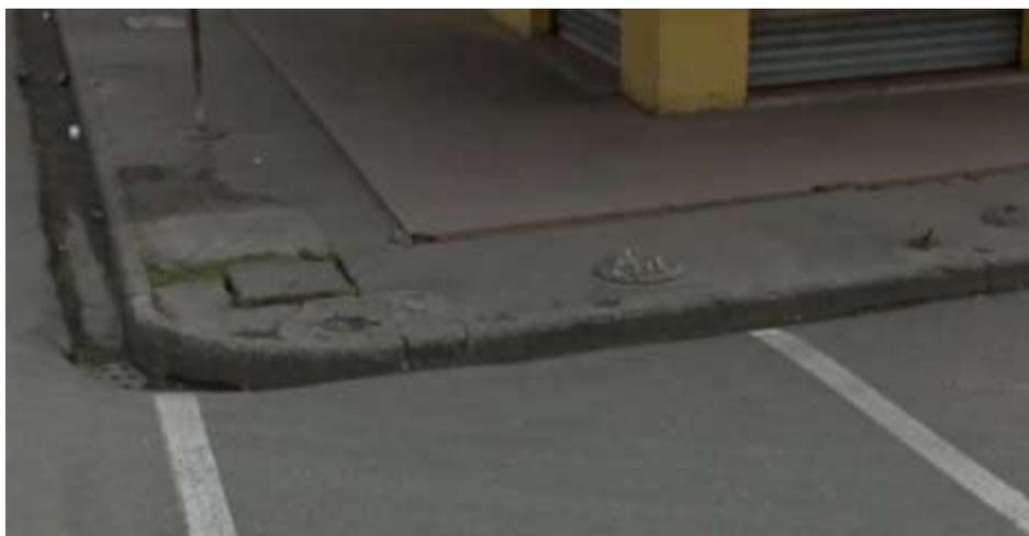
**Figura 3.2. Sumidero pluvial ubicado en la intersección de las calles 24 de Mayo y Los Chirijos.**
