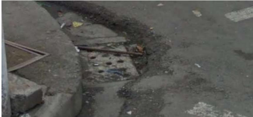
**Fig. 3.12.** Presencia de puntos de drenaje compuestos por tapas de hormigón con aberturas circulares y caja de revisión en la intersección de las calles 24 de Mayo y Miguel Valverde.
