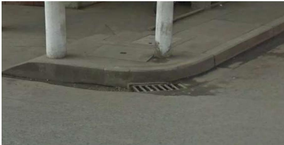
**Fig. 3.8.** Visualización de punto de drenaje pluvial (metálico) y canaletas de direccionamiento de aguas pluviales en la intersección de las calles 24 de Mayo y 9 de Octubre.
