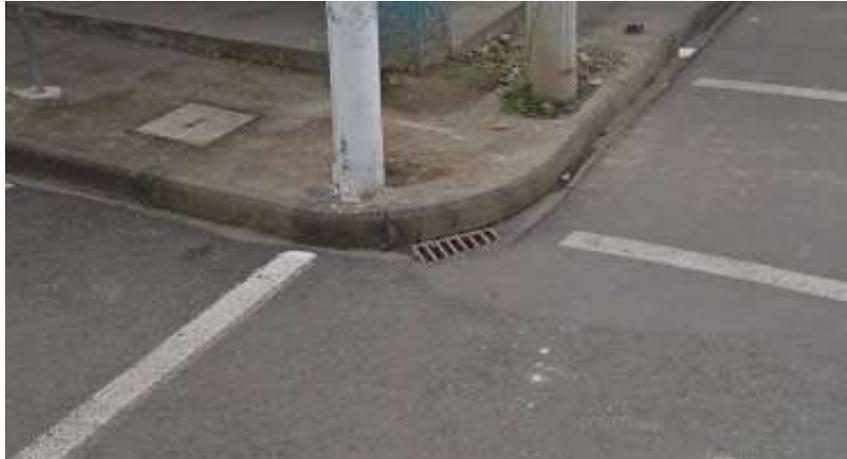
**Fig. 3.5** Sumidero pluvial (metálico) ubicado en la intersección de las calles 24 de Mayo y Simón Bolívar.
