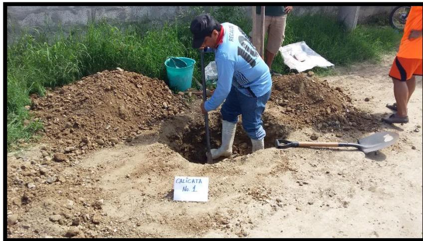
**Figura 10.-** Calicata #1 con coordenadas  $X=528380.6810$ ,  $Y= 9795535.7180$ .
