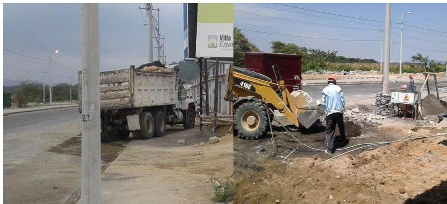
**Figura 4.13.** Limpieza de la obra con maquinaria
