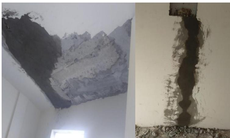
**Figura 4.11.** Trabajos rehechos en la construcción
