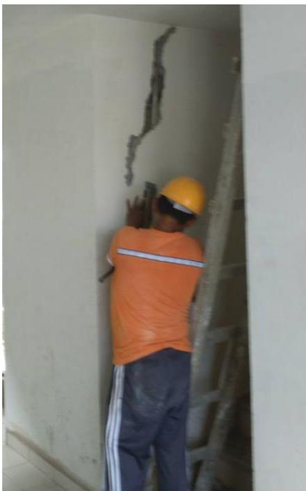
**Figura 4.8.** Colocación de instalaciones eléctricas olvidadas
