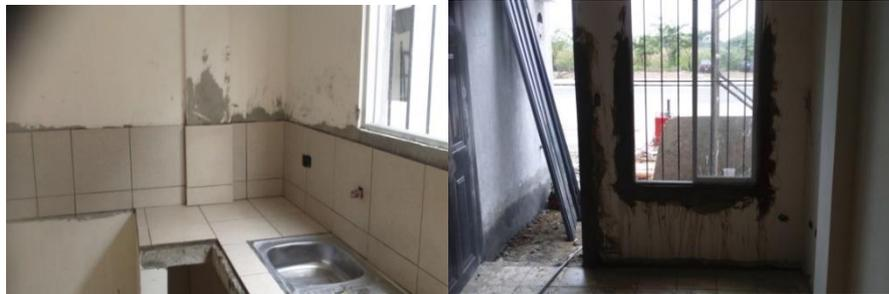
**Figura 4.7.** Descoordinación entre trabajos.
