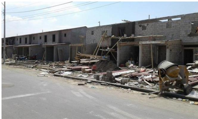
**Figura 4.12.** Acumulación del material desechado
