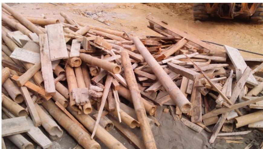
**Figura 4.6.** Madera para encofrado desperdiciada.
