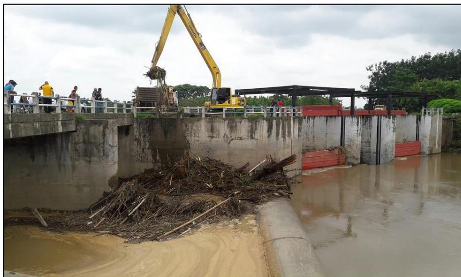
**Figura 3.18:** Palizada en la represa.
