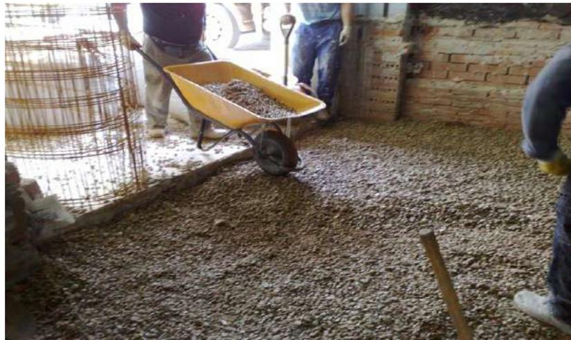
**Figura 6. 5** Solado de interior de un local
