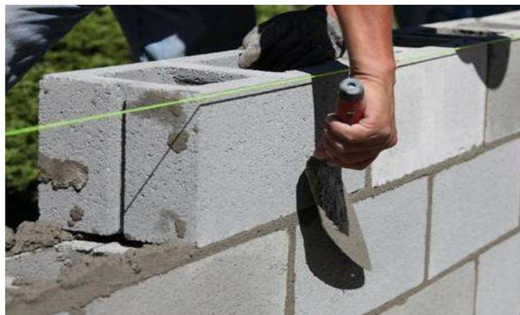
**Figura 6. 4** Construcción de muro con bloque
