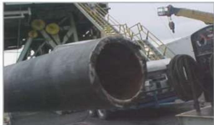
Figura 2.15 Tubería cortada con herramienta hydra blast pro
