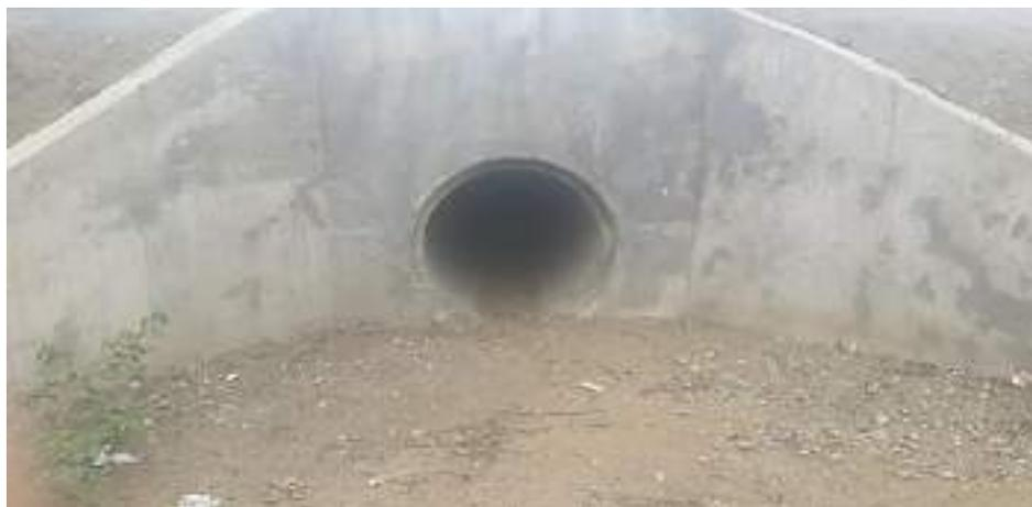
**Figura 2.7** Alcantarilla en la carretera para drenaje de aguas lluvias
