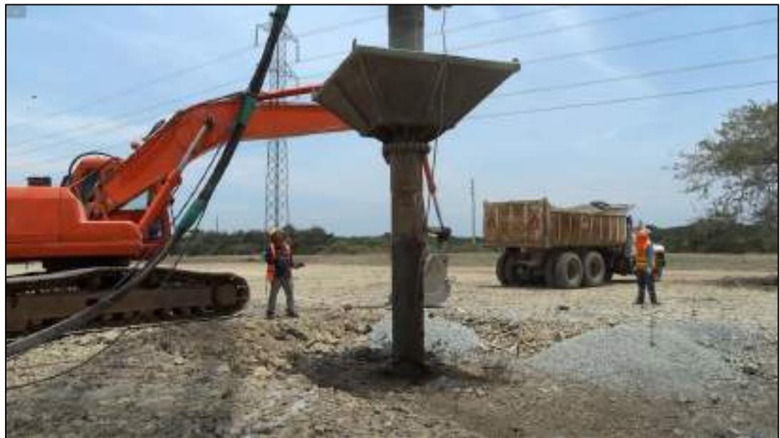
**Figura 6.1.** Prueba de columnas de grava en la PTAR Las Esclusas.
