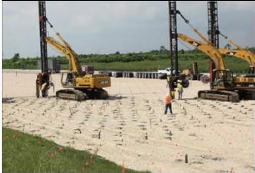
**Figura 6.3.** Colocación de Wick Drains.
