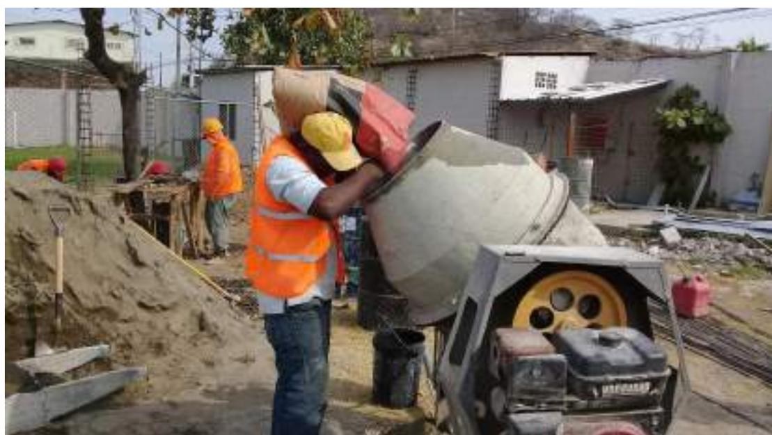
**Figura 3. 43** Vertido de cemento portland en concreteira.
