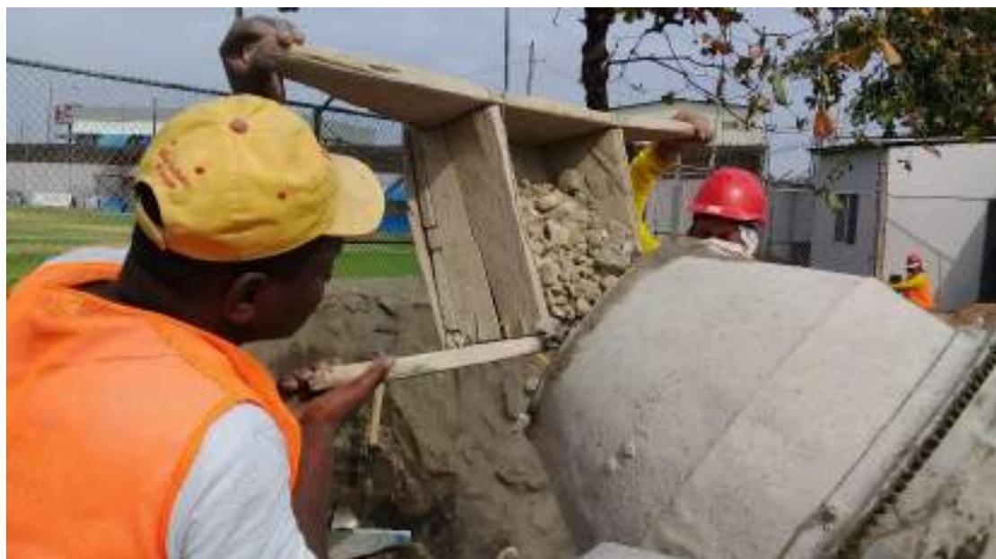
**Figura 3. 42** Vertido de agregado grueso en concreteira.
