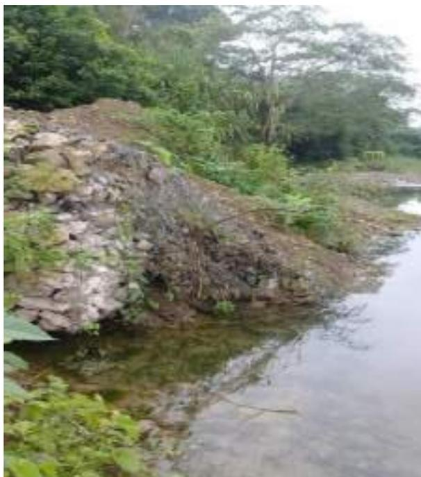
**Figura 3. 2** Antiguo tape de gaviones, destruido por efecto de la corriente del río.
