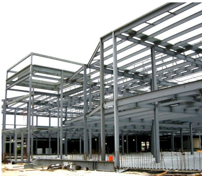
Figura 2.1. Pórtico Resistente a momento de centro comercial
