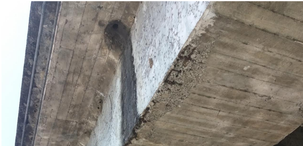
Fotografía 4.18: Estado actual, vigas cajón del tramo 4.
