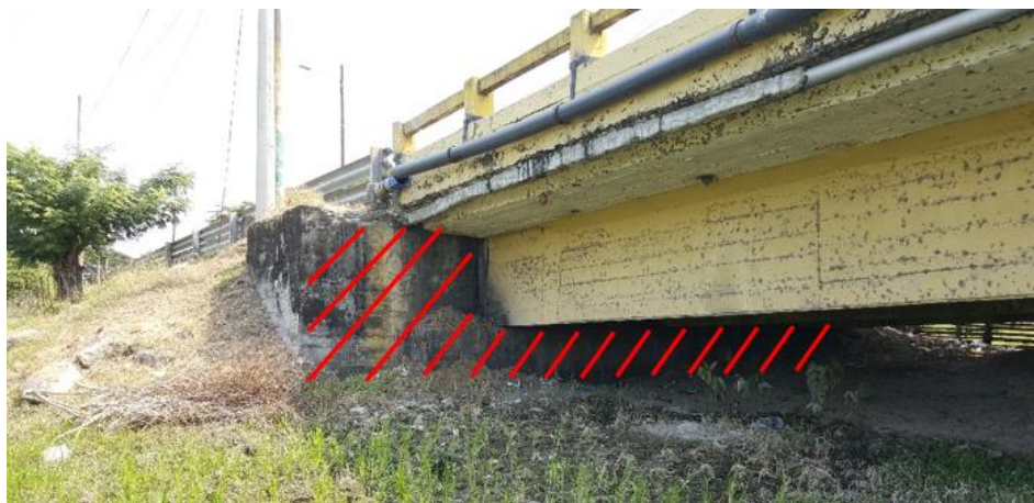
Figura 5.8: Área de aplicación de rehabilitación en el estribo 1. Fuente: Autores.
