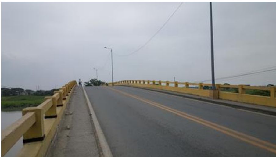
Fotografía 4.2: Tablero del Puente de Tarifa. Fuente: Autores.
