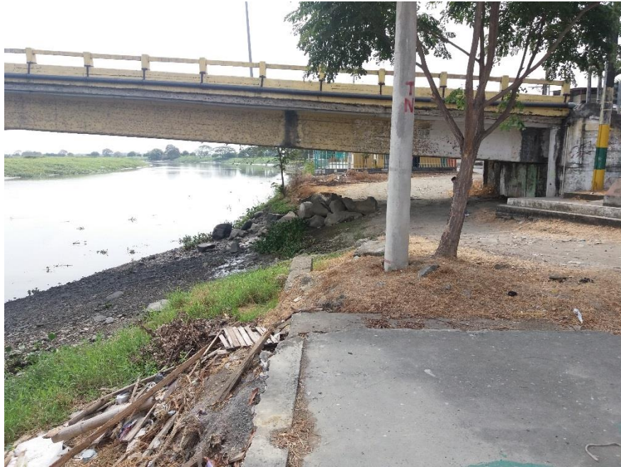
Fotografía 4.37: Talud 1. Tarifa – Boca de Caña.
