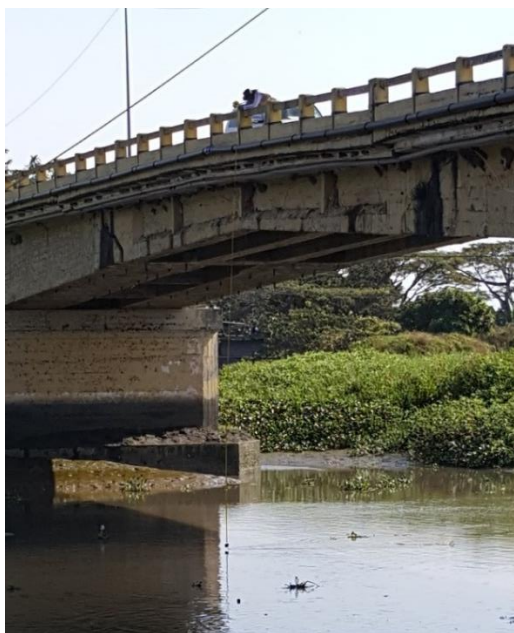
Fotografía 4.8: Medición del galibo del puente de Tarifa, Junio 2016.
