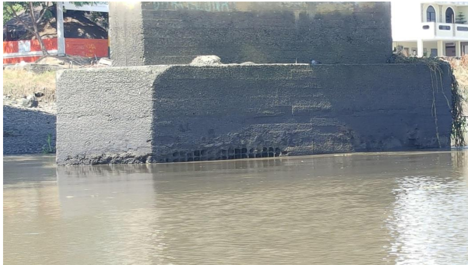
Fotografía 4.34: Estado actual, cimentación de la pila P3.
