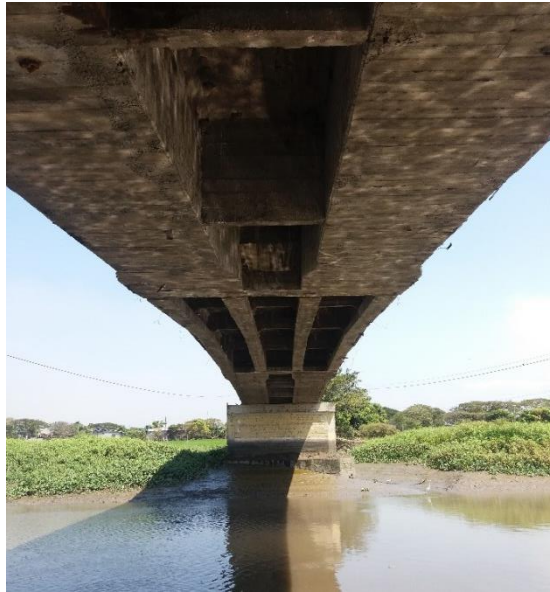
Fotografía 4.6: Vigas y diafragmas del puente de Tarifa en el tramo # 3. Fuente: Autores.
