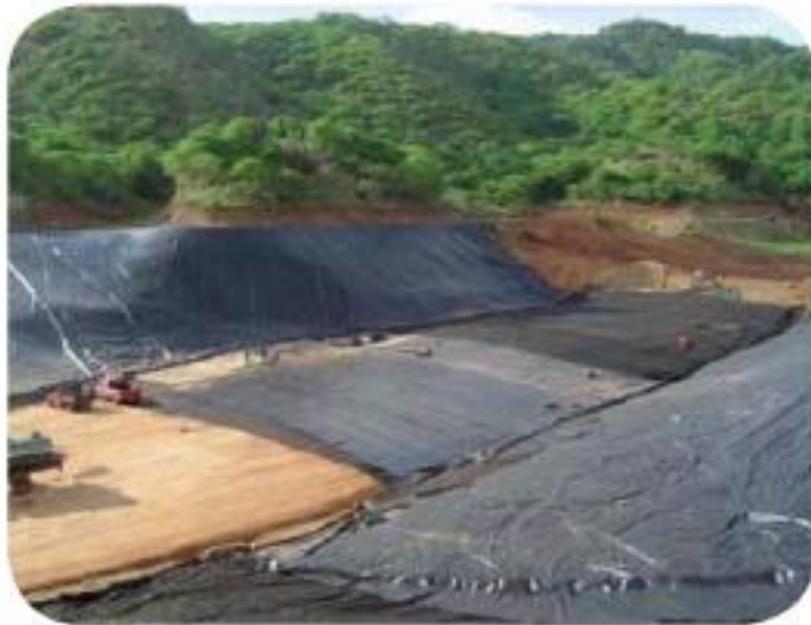
**Figura 3.9:** Geotextil aplicado en un relleno sanitario
